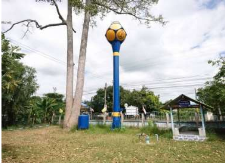
หอส่งน้ำ (ประปาโรงเรียน)
