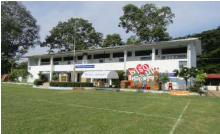
อาคารเรียน สปช.๑๐๕/๒๙ หลังที่ ๒ (ห้องเรียน ป.๕ ป.๖ และห้องวิชาการ)
