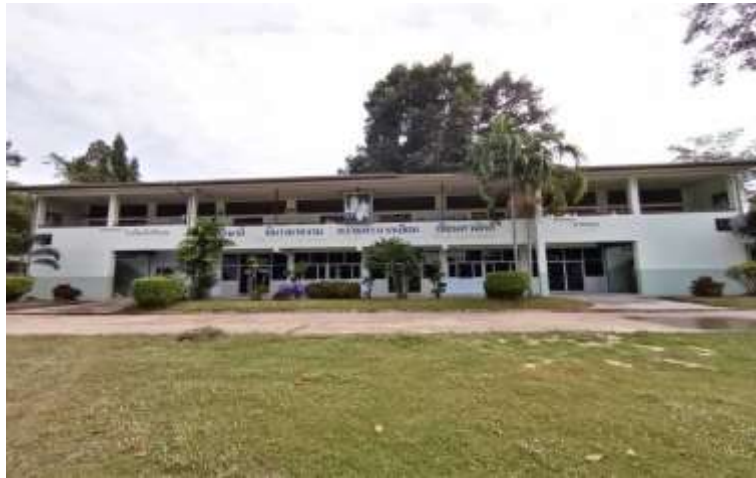
อาคารเรียน สปช.๑๐๕/๒๙ หลังที่ ๑ (ห้องเรียน ม.๑ ม.๒ ม.๓ และห้องประชุม)
