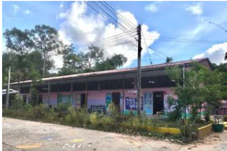
อาคารเรียน สปช. ๑๐๒/๒๖ (ห้องเรียน อ.๒ อ.๓ ป.๑)
